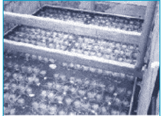
Tanque de aireación de barros activados
