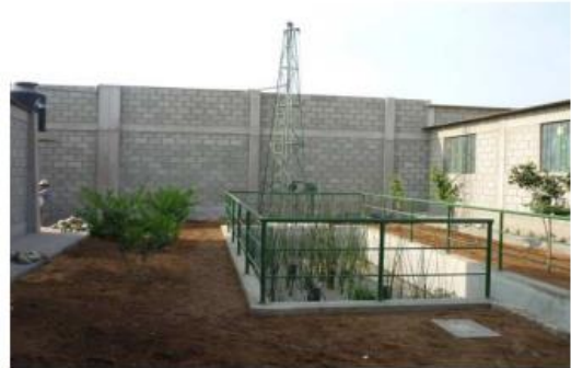
Fig. 7: En primer plano el humedal, en la parte posterior la bomba de mecate y a la izquierda el tanque elevado (R. Miglio, 2009).
