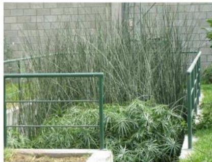
Fig. 9: Vista del humedal luego de 9 meses de instalación, se observan las áreas verdes generadas por el riego con agua tratada (H. Esquerre, 2010).
