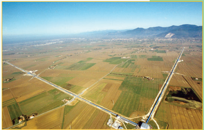
Figura 10.14. Vista aérea del detector VIRGO de 3 km de lado, cerca de Pisa, Italia.
