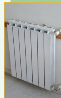
Figura 5.6. Ejemplo de un radiador por el que circula agua caliente.
