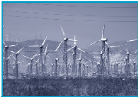
Granja eólica situada en las montañas de San Bernadino (Palm Spring, California, EEUU); posee más de 4.000 aerogeneradores instalados montados sobre torres de estructura metálica o celosías. www.freefoto.com
