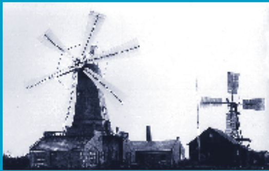
Dos de los aerogeneradores de prueba del Instituto de Askov Folk, Askov (Dinamarca), en 1897. Este instituto, fundado por P. Lacour todavía existe, manteniendo los molinos de viento en su estado original. Danish Wind Industry Association. www.windpower.org
