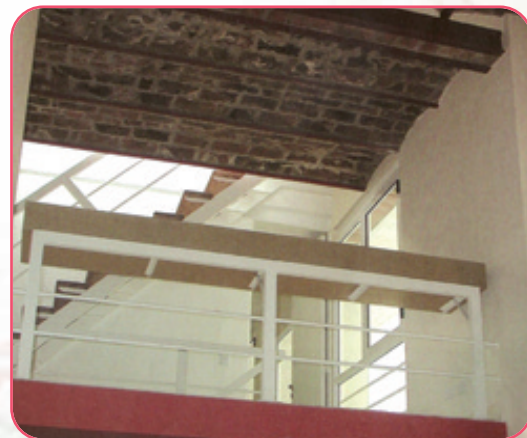
Imagen 5.17. Techo con viguetas de acero y ladrillos
