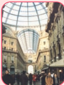
Imagen 5.47 f. Arcos que soportan la cubierta vidriada de la Galería Médici. Milán – Italia
